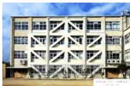
耐震化の状況（②伏見住吉小学校）
