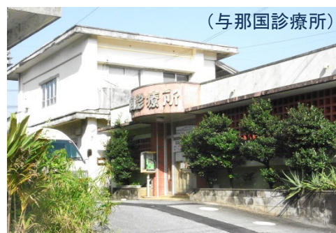
町内における広域医療の中心施設
