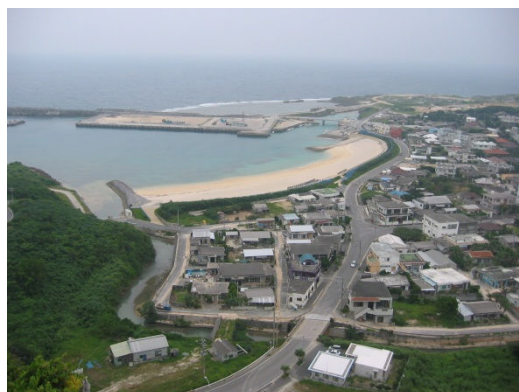
島の物流拠点である祖納港
